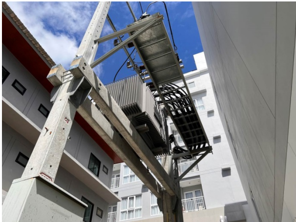
ภาพที่ 1-13 หม้อแปลงไฟฟ้าของโครงการ
