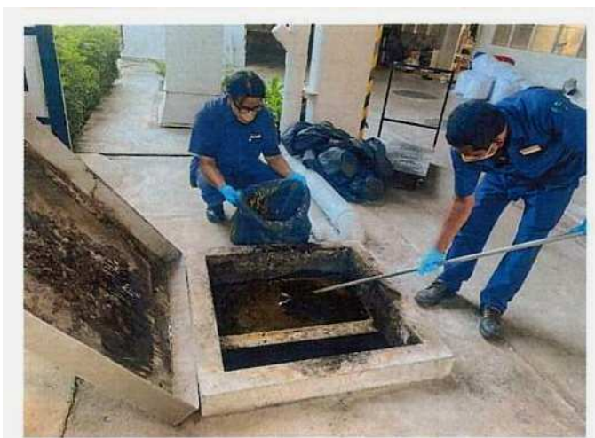
ภาพที่ 1-8 เจ้าหน้าที่ดักไขมัน และมิเตอร์ไฟฟ้าสำหรับระบบบำบัดน้ำเสีย
