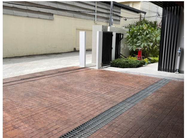
ภาพที่ 1-10 ระบบระบายน้ำฝนของโครงการ
